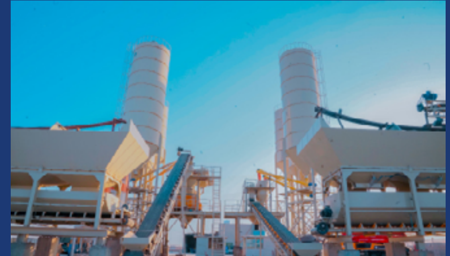
مصانع الخرسانة Concrete plants
